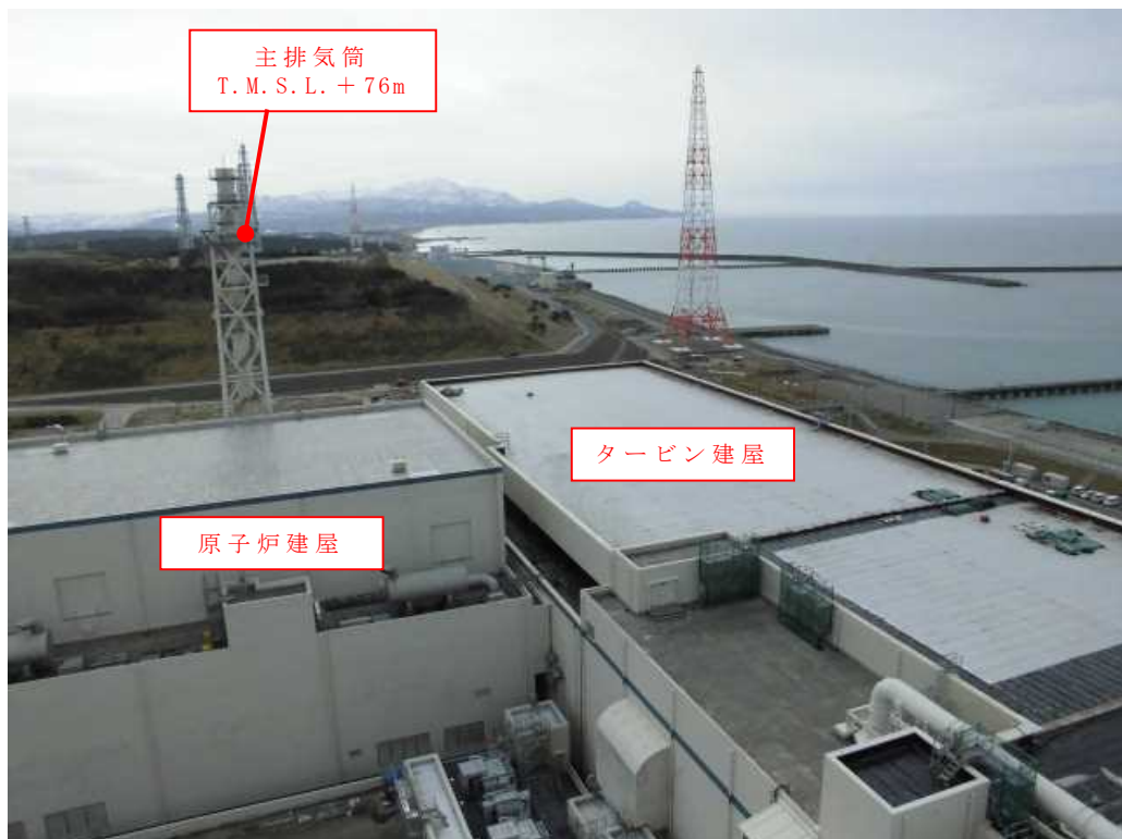
第 4.3-2 図 津波監視カメラ設置位置
