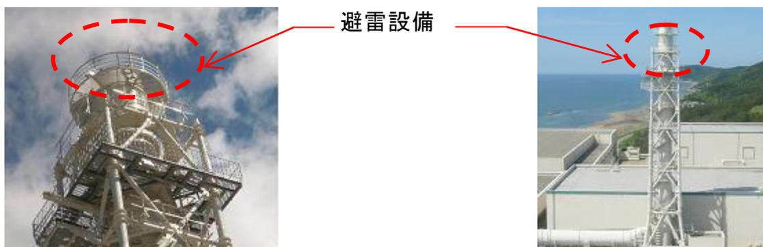
第 1-16 図：避雷設備の設置例（主排気筒）
