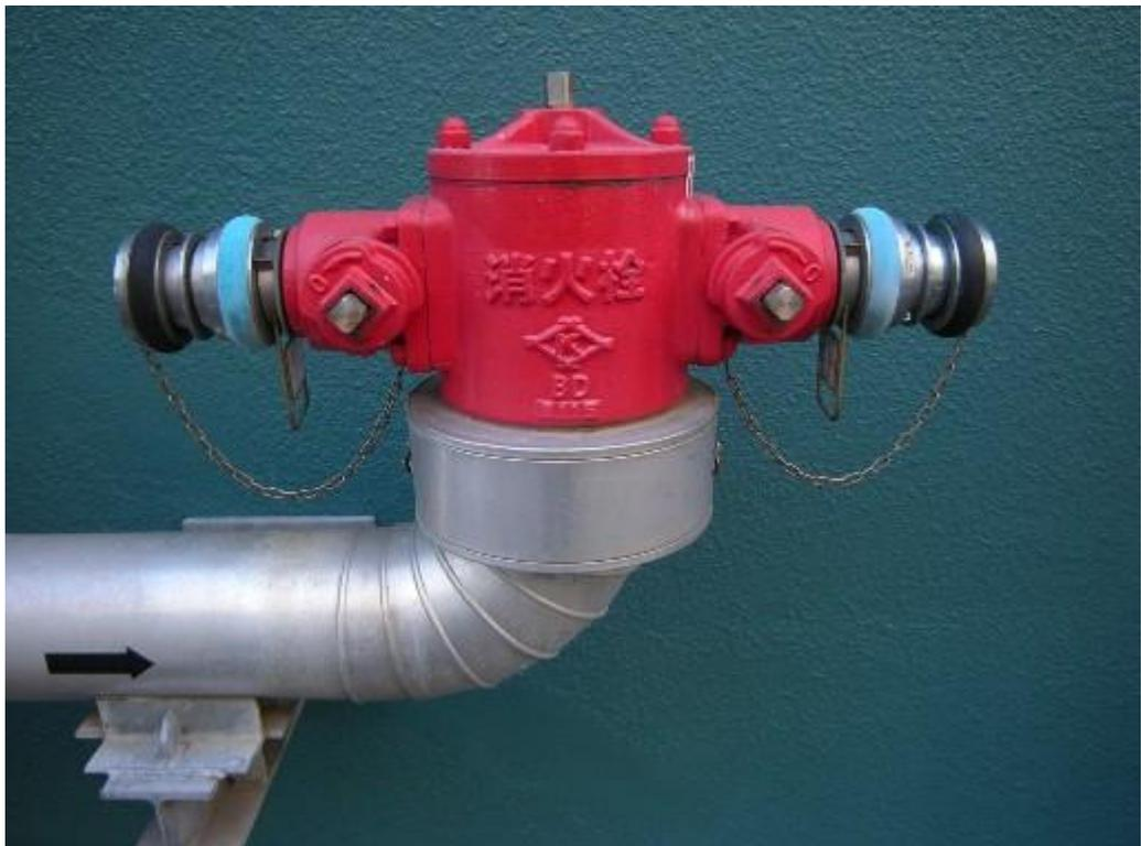
第 1-32 図：不凍式消火栓の設置状況
