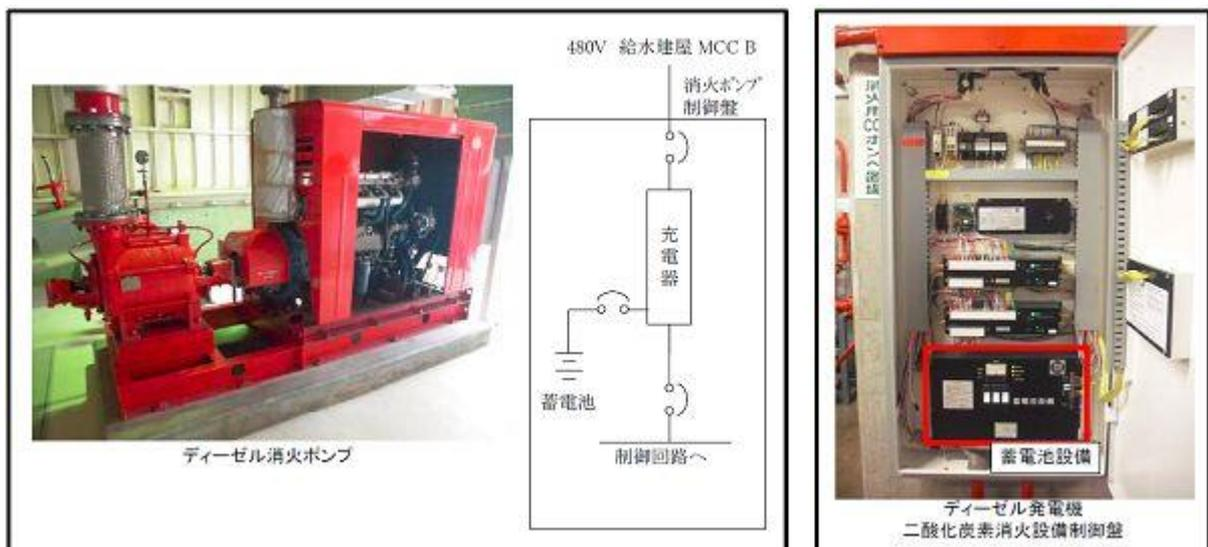
第 1-27 図：消火設備の電源確保の概要
