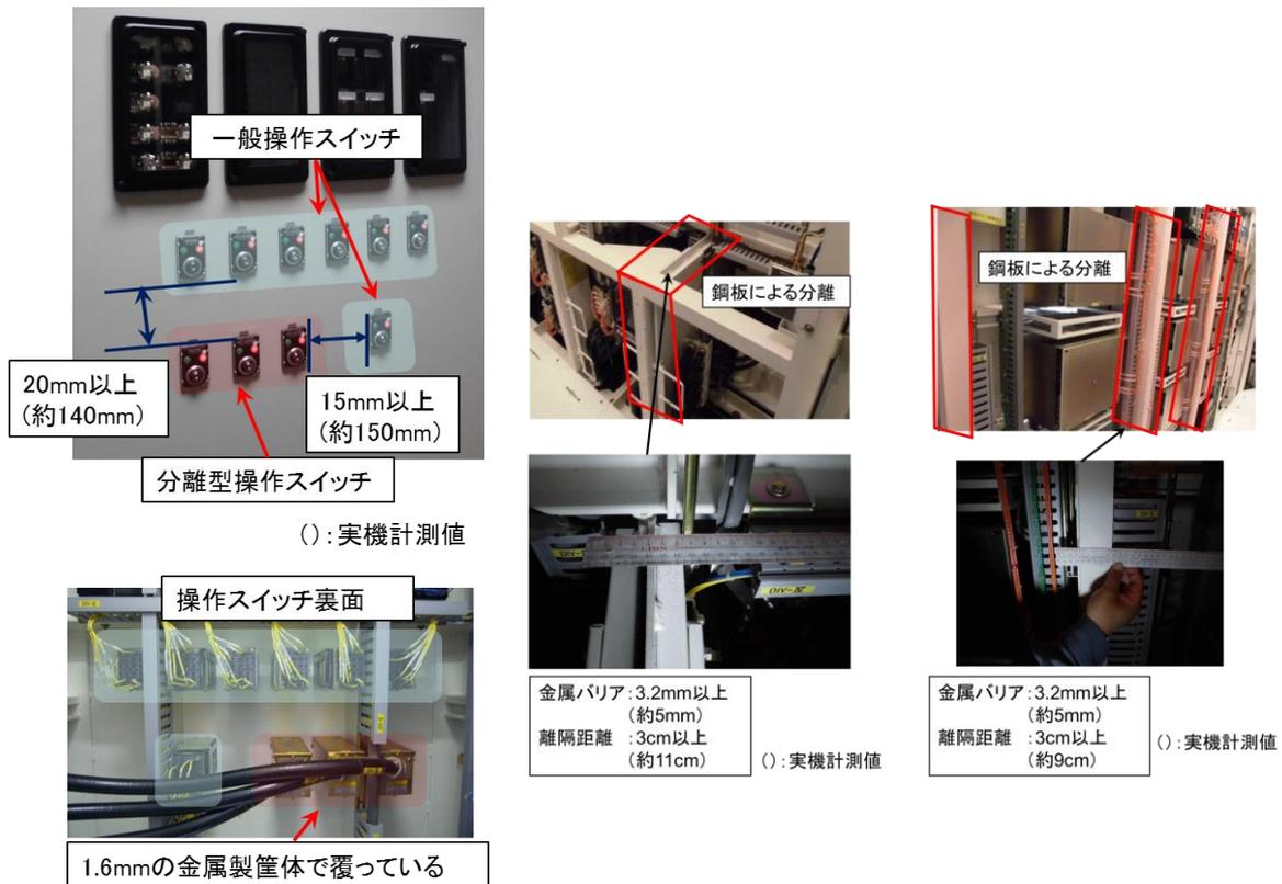
第 7-3 図：中央制御盤内のバリア状況
