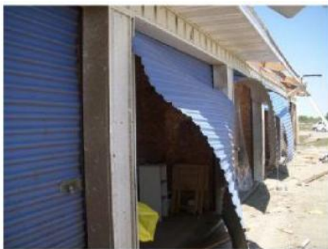
図 6 平成 20 年 5 月 25 日米国アイオワ州にて発生した EF5 竜巻によるシャッター被害状況 (6)
