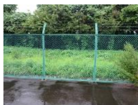
⑤-10 鋼製フェンス
