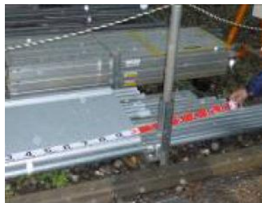
①-8 鋼製パイプ
