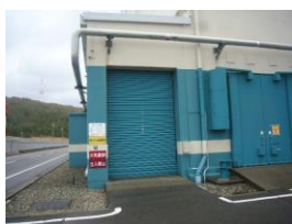
①-23 シャッター, 配管
