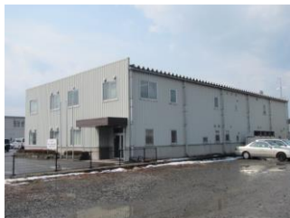
④-10 屋根, 外壁
