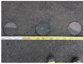
④-16 排水溝蓋
