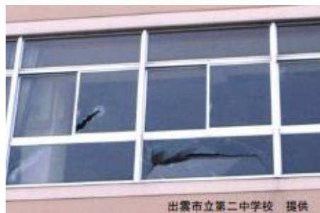
体育館窓ガラスの破損
