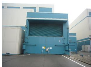
①-13 シャッター (大物搬入口)
