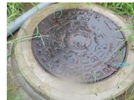
③-39 マンホール蓋
