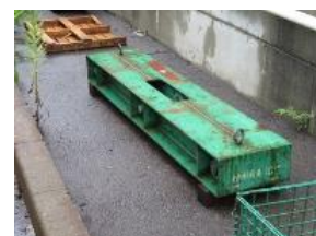
④-30 仮設鉄骨
