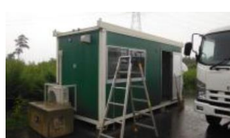
⑥-12 仮設小屋
