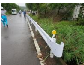
⑤-7 ガードレール
