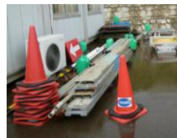
⑦-30 仮設足場板
