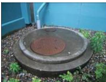
①-16 マンホール蓋
