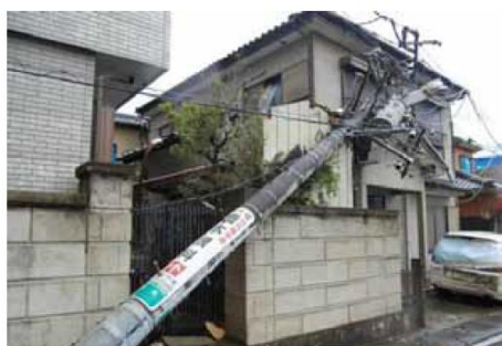
(電柱の折損、傾斜)
