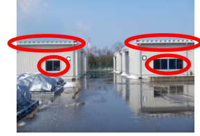
⑤-12 窓ガラス, 屋根
