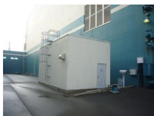
①-20 扉, 換気フード, 猿梯子
