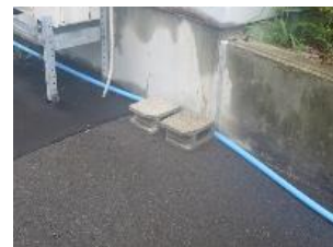
④-24 コンクリートブロック
