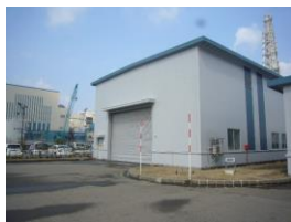
①-16 屋根, シャッター
