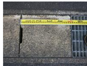
④-3 コンクリート板 (排水溝蓋)
