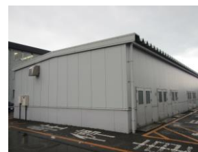
④-24 屋根, 外壁
