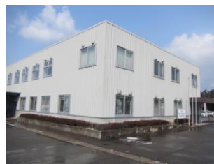
④-11 窓ガラス
