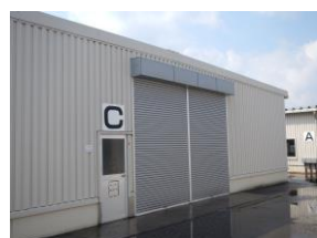
⑤-7 シャッター, 扉
