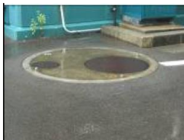
①-17 マンホール蓋
