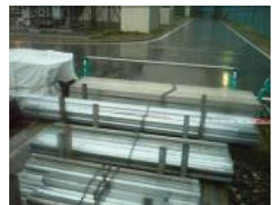
①-9 仮設足場板
