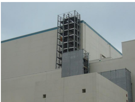
図 21 柏崎刈羽原子力発電所における仮設足場の状況
