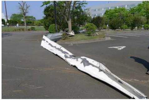
飛散した鋼板製屋根材
