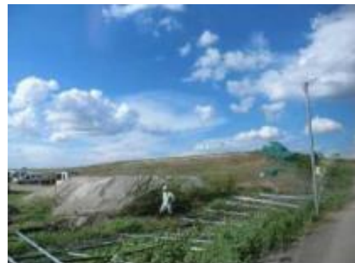
フェンスの被害
