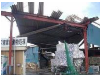
折板の損傷
