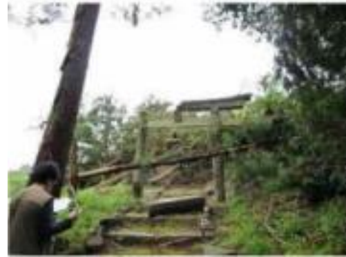
倒木の折損と鳥居の被害
