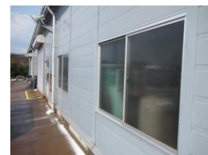
④-12 窓ガラス
