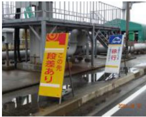
⑦-19 工事看板
