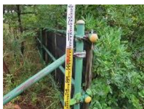
④-10 フェンス（単管柵）
