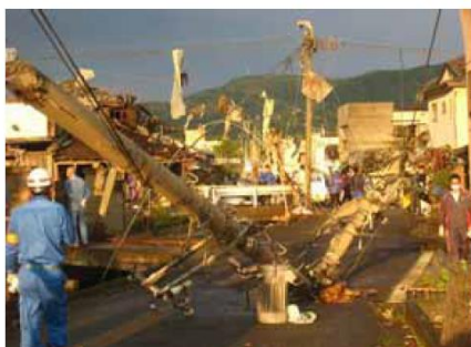
(電柱の折損、傾斜)
