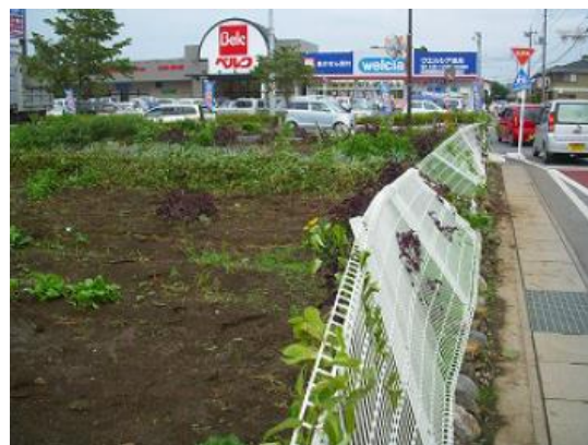
フェンスの変形
