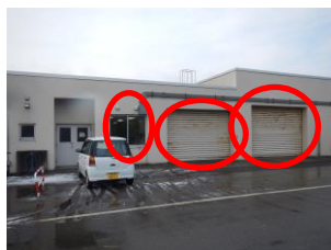
⑤-2 シャッター, 窓ガラス
