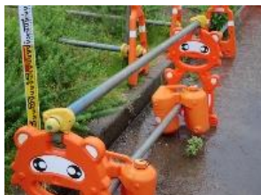
③-2 鋼製車止め (単管バリケード)
