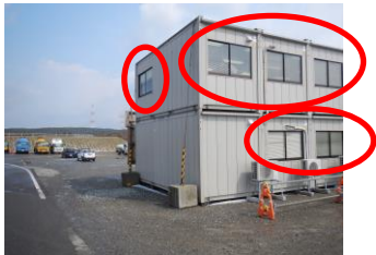
③-1 窓ガラス
