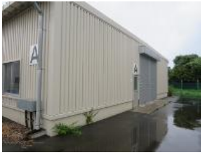
⑤-13 屋根, シャッター
