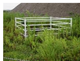
③-12 鋼製フェンス
