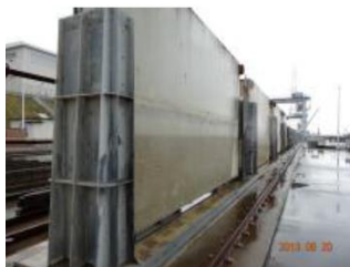
⑦-8 コンクリート板
