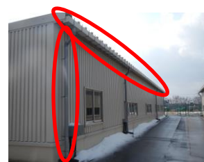
⑤-6 配管, 雨樋
