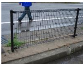
④-40 鋼製フェンス
