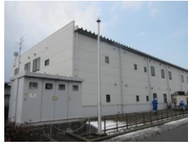
④-1 屋根, 外壁
