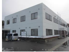
④-2 窓ガラス
