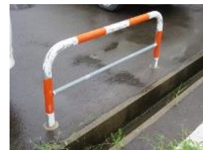
④-57 鋼製フェンス
