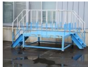
④-38 鋼製架台
