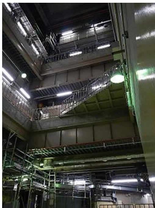
7号炉原子炉建屋 2～3階 機器ハッチの状況
