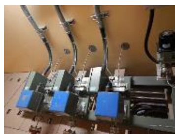
TIP 駆動装置及び可とう電線管
