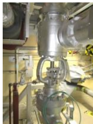
電動弁及び可とう電線管
