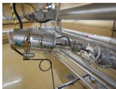
空気作動弁及び可とう電線管
