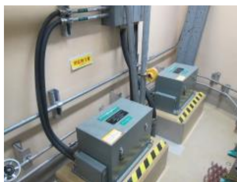
地震観測装置及び可とう電線管
