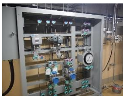
サンプリングトランスミッタ盤
