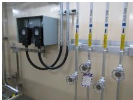
計器及び可とう電線管
