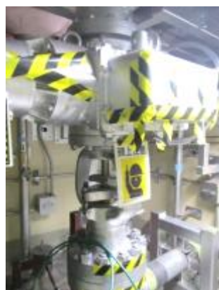
電動弁及び可とう電線管
