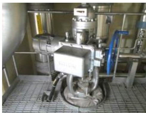
電動弁及び可とう電線管
