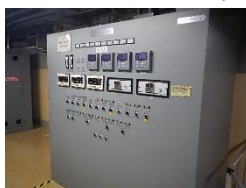
サンプリングトランスミッタ盤
