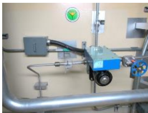
電磁弁及び可とう電線管
