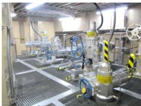
電動弁及び可とう電線管
