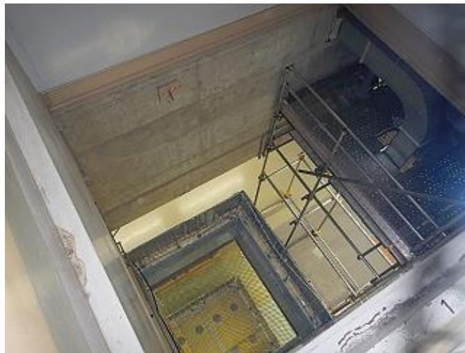
7号炉原子炉建屋 地下2～地下1階 機器ハッチの状況
