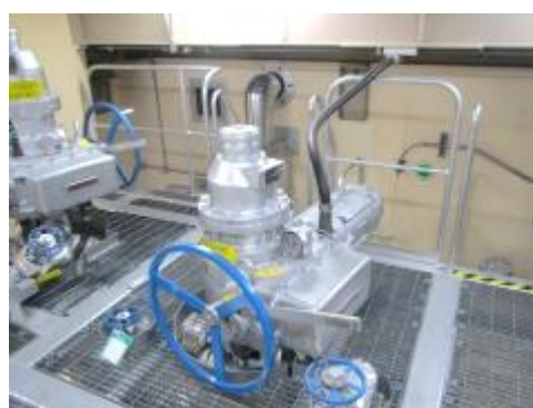
電動弁及び可とう電線管
