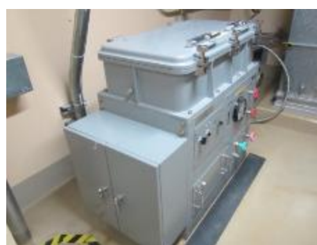
ダストサンプラ及び可とう電線管
