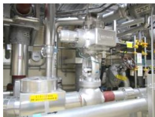
電動弁及び可とう電線管
