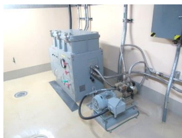
ダストサンプラ 及び可とう電線管
