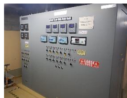
サンプリングトランスミッタ盤
