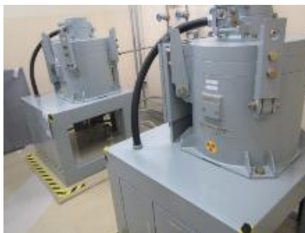
放射線モニタ及び可とう電線管
