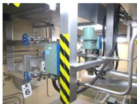
電磁弁及び可とう電線管
