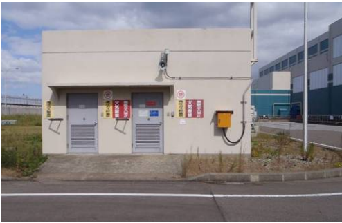
発電機用水素ガスボンベ建屋（6号炉）
