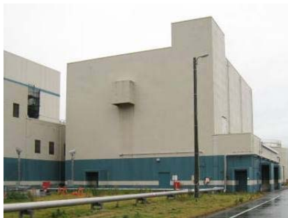
雑固体廃棄物焼却設備建屋（大湊側）
