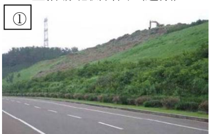
土捨場北側斜面（近景）
