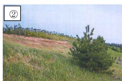
大湊側高台保管場所西側斜面（近景）
