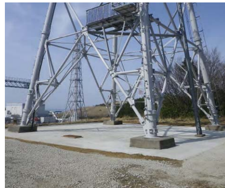
南新潟幹線 No. 1 送電鉄塔
