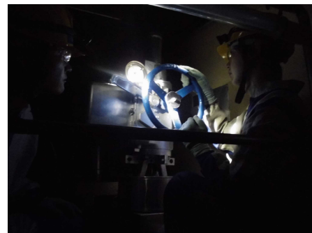
可搬型照明を使用した状態での作業
