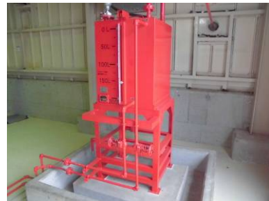
給水建屋 ディーゼル消火ポンプ燃料タンク設置状況
