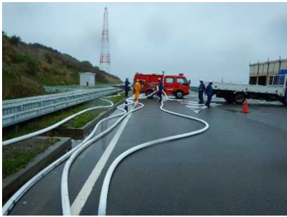
可搬型代替注水ポンプ（中継用） の設置（大湊側高台保管場所の西 側周辺）
