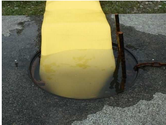
大容量送水車（海水取水用）による防火水槽への海水補給（防火水槽周辺）
