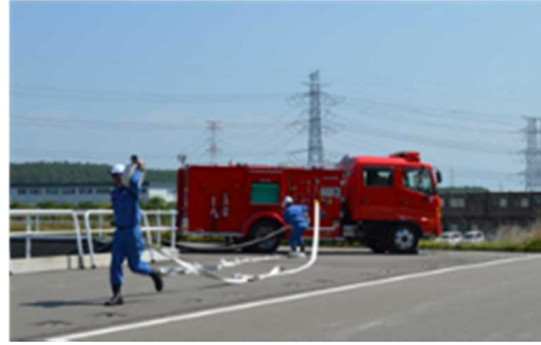
化学消防自動車と大型化学高所放水車のホース接続状況
