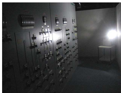
第2図 裏盤における可搬型蓄電池内蔵型照明確認状況
