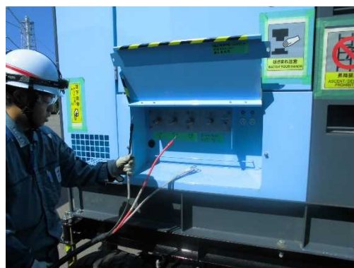
CVケーブル接続 (給水建屋周辺)
