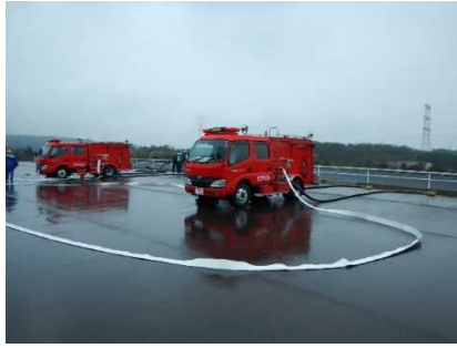
可搬型代替注水ポンプ（取水用） の設置（淡水貯水池周辺）
