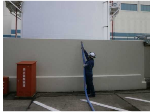
軽油タンクへのホース接続
