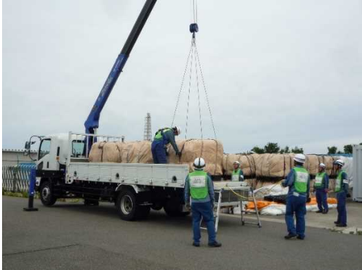
積み込み状況（訓練）
