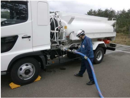
タンクローリへのホース接続
