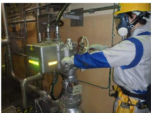
現場での注水操作（残留熱除去系(A)，(B)注入配管使用の場合）
