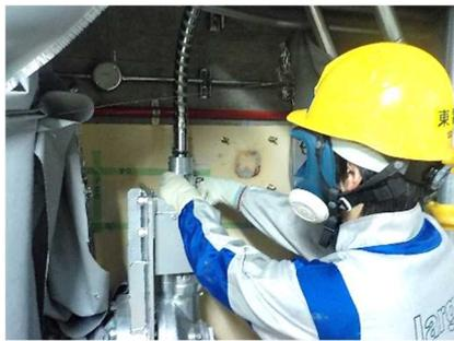
リンク機構の取外し操作
