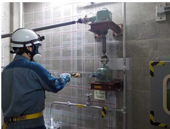
ベント操作（遠隔手動弁操作設備）
