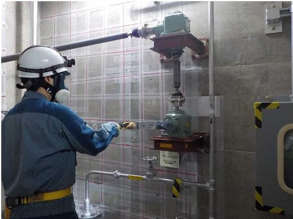
系統構成 (遠隔手動弁操作設備)
