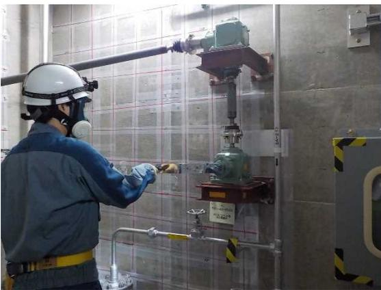
系統構成（遠隔手動弁操作設備）
