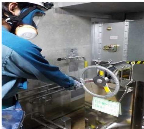
系統構成（遠隔手動弁操作設備）
