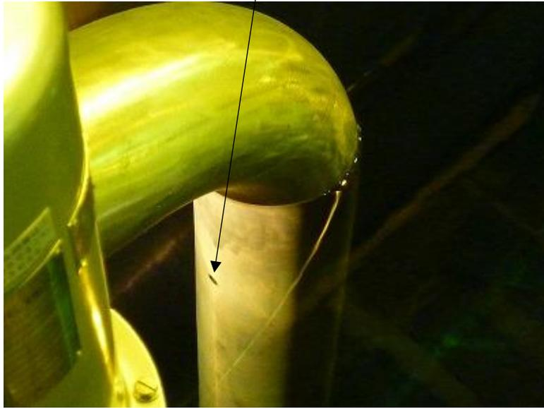
図5 サイフォンブレーク孔の設置状況
