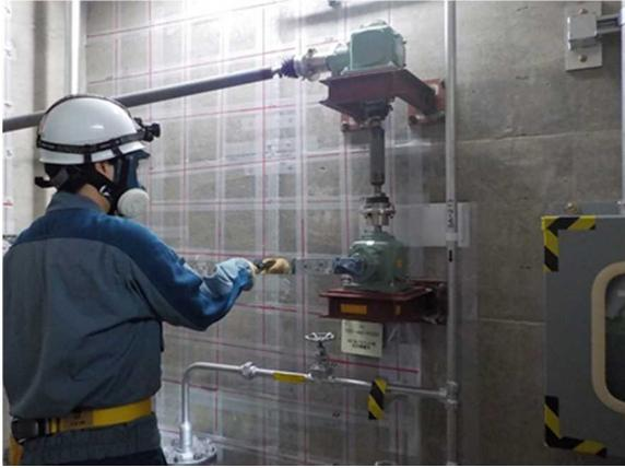
系統構成（遠隔手動弁操作設備）
