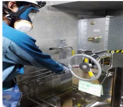
系統構成（遠隔手動弁操作設備）
