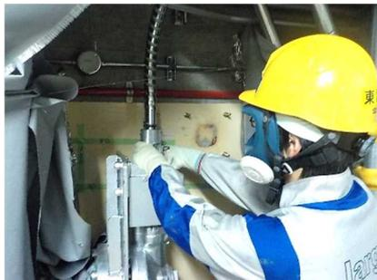
リンク機構の取外し操作
