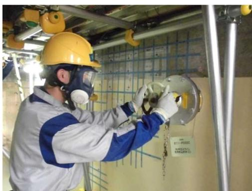
現場での注水操作（残留熱除去系(C)注入配管使用の場合）
