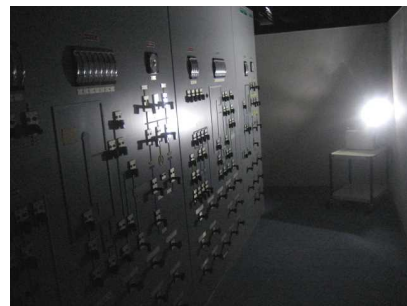
図 2.5-7 裏盤における可搬型蓄電池内蔵型照明確認状況
