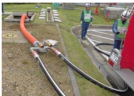
ホースと可搬型代替注水ポンプ吸管との接続 (防火水槽周辺)
