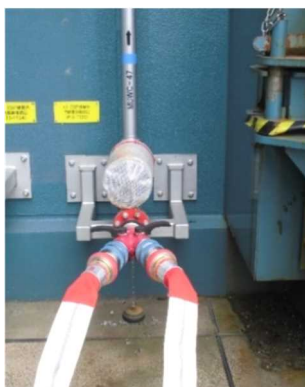
ホースをCSP大容量接続口に接続 (廃棄物処理建屋周辺)
