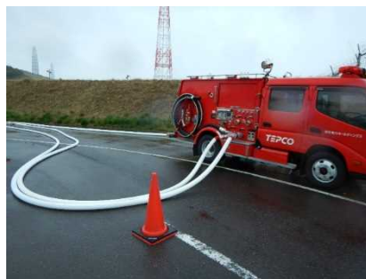
可搬型代替注水ポンプ（先車）の 設置（タービン建屋周辺）
