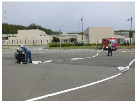
ホースを建屋接続口まで敷設
