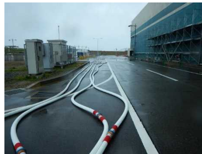
可搬型代替注水ポンプ（中継用） から可搬型代替注水ポンプ（送水 用）までのホース敷設
