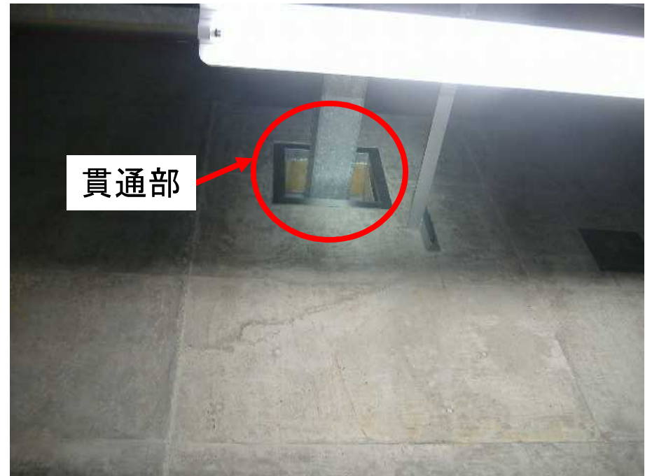
4号機原子炉建屋 地下5階 (通路)
