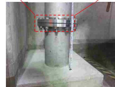
e 部 ベント管接合フランジ部
