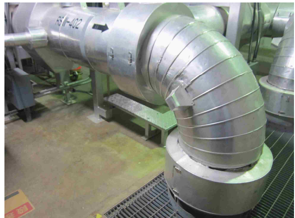
第 2.3-2 図 原子炉補機冷却海水系配管貫通部 (6号炉)
