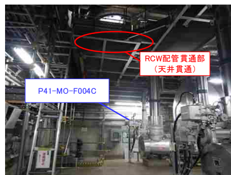
P41-MO-F004C 現場状況
