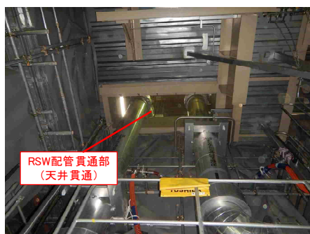
原子炉補機冷却海水系配管貫通部 (天井貫通) 現場状況
