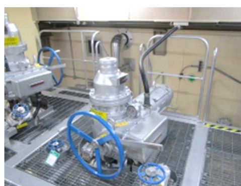
電動弁及び可とう電線管
