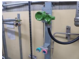
原子炉系多重伝送現場盤
