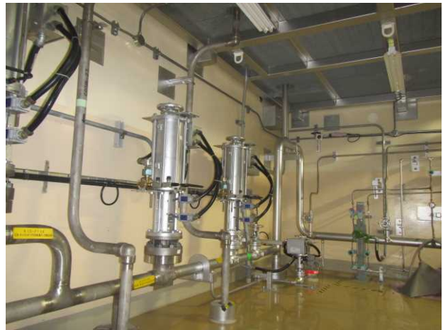
HCW 放出ラインのバルブの配置 (HCW バルブ室)
