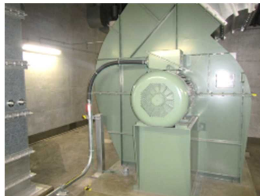
送風機、電動機及び可とう電線管
