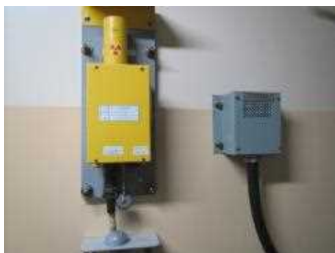
エリアモニタ及び可とう電線管
