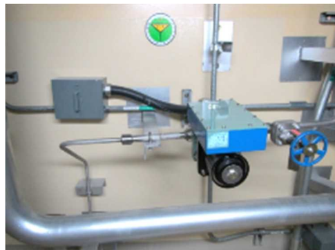
電磁弁及び可とう電線管
