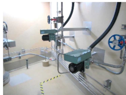
電磁弁及び可とう電線管
