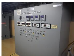
サンプリングトランスミッタ盤
