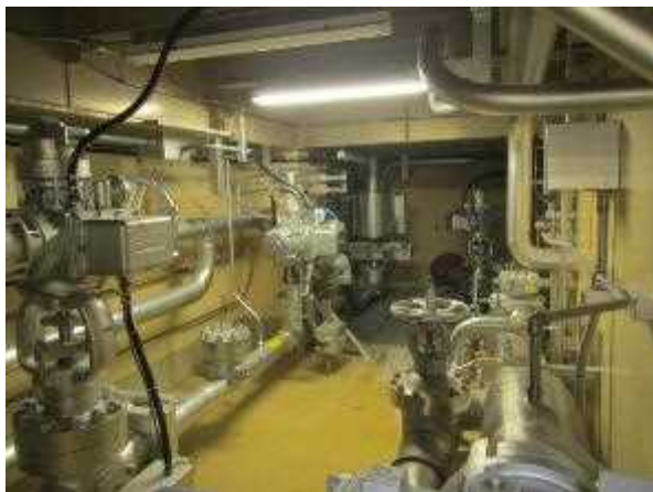
電動弁及び可とう電線管
