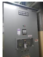
CRD 駆動水加熱器盤
