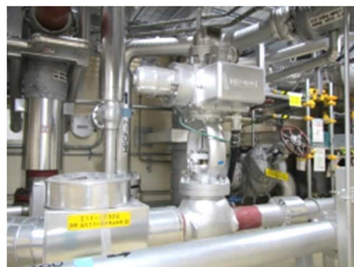
電動弁及び可とう電線管
