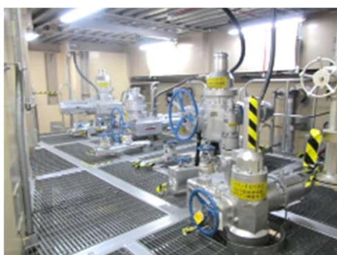
電動弁及び可とう電線管
