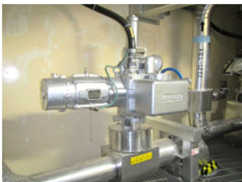
電動弁及び可とう電線管
