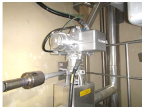
電動弁及び可とう電線管
