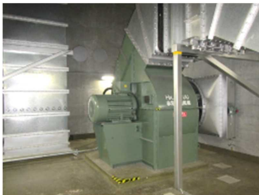
送風機、電動機及び可とう電線管
