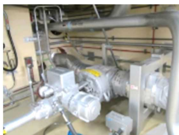
電動弁及び可とう電線管
