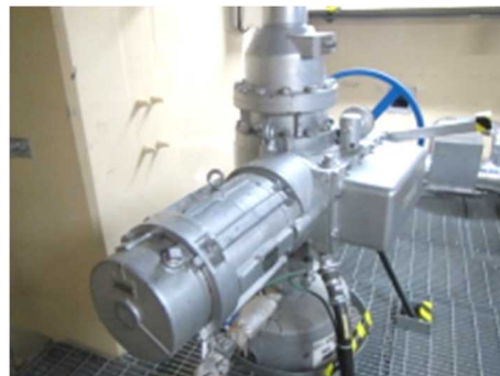
電動弁及び可とう電線管
