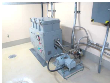
ダストサンプラ 及び可とう電線管
