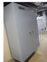
電磁弁盤
