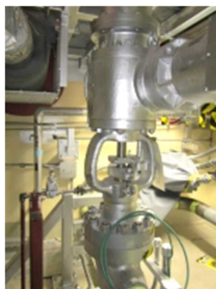
電動弁及び可とう電線管
