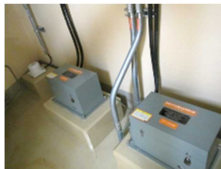
地震観測装置及び可とう電線管
