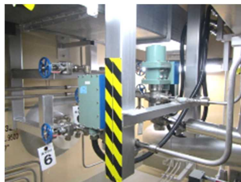
電磁弁及び可とう電線管
