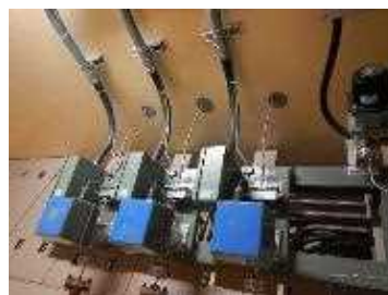
TIP 駆動装置及び可とう電線管
