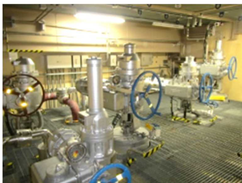
電動弁及び可とう電線管
