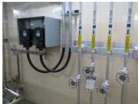
計器及び可とう電線管
