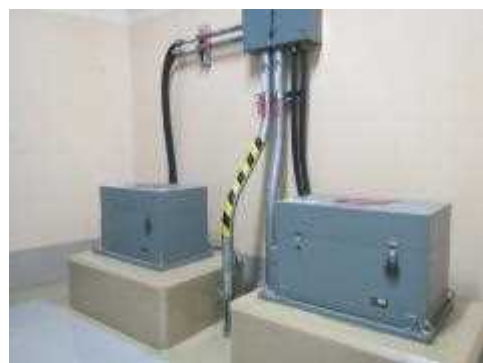
地震観測装置及び可とう電線管
