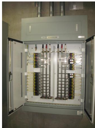
配線用遮断器の例 (ブレーカー)
