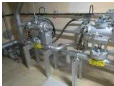
空気作動弁及び可とう電線管
