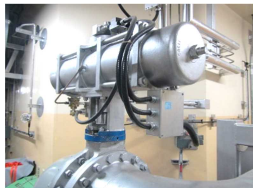
空気作動弁及び可とう電線管
