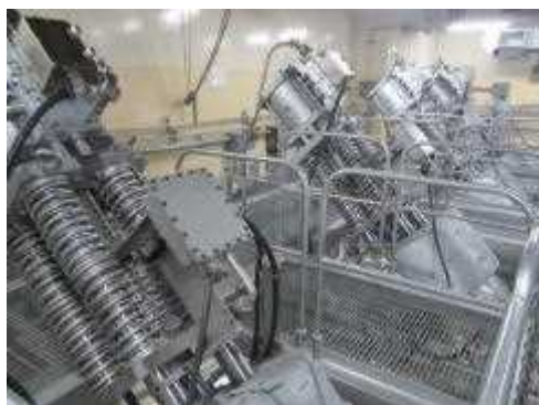
主蒸気隔離弁
