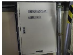
原子炉系多重伝送現場盤
