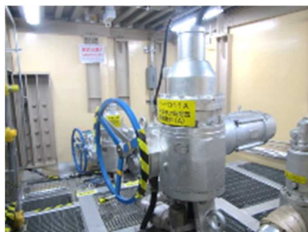
電動弁及び可とう電線管
