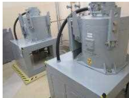
放射線モニタ及び可とう電線管
