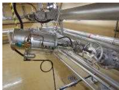
空気作動弁及び可とう電線管
