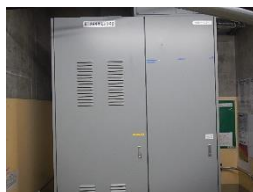
原子炉系多重伝送現場盤
