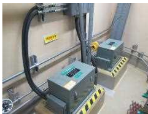
地震観測装置及び可とう電線管
