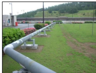
消火配管の地上化
