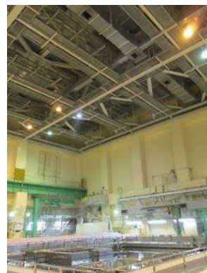
使用済燃料プール上部天井
