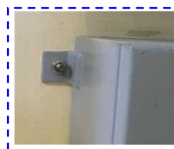
ボルトによる壁面固定
