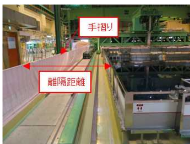
②使用済燃料プール南側側面
