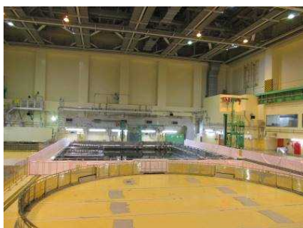
原子炉建屋オペレーティング フロアの床面全体
