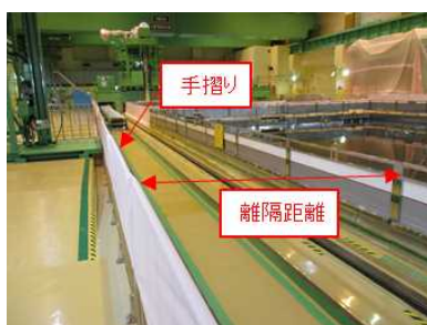
②使用済燃料プール南側側面
