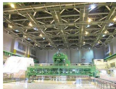
使用済燃料プール上部天井
