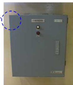
ボルトによる壁面固定
