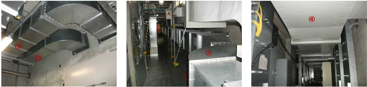
図 2.1.4-3 バウンダリ外ダクト敷設状況
