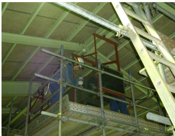
図 2.1.4-8 ダクト修復 作業訓練の例
