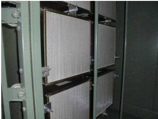
(高性能フィルタの取付け状態)
