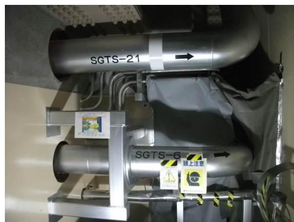
配管補修箇所（可搬型照明2台使用）
