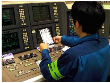
第 2.4.3-5 図 中央制御室におけるタグ札運用
