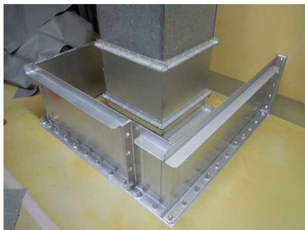
添付第 1.2.2-1 図 ダクトに対する溢水対策
