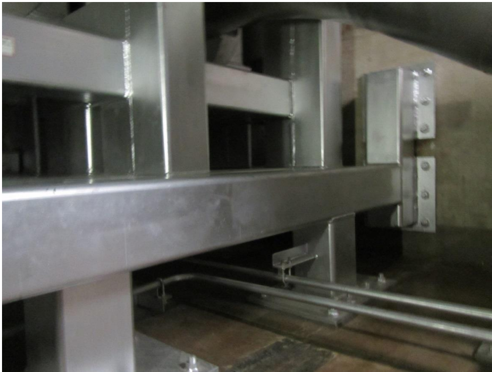
RCW (A) 配管サポート 外観
