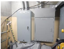
ケーブル分岐箱，分電盤
