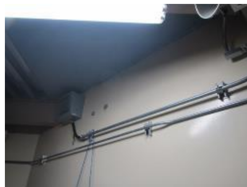
エリアモニタ及び可とう電線管
