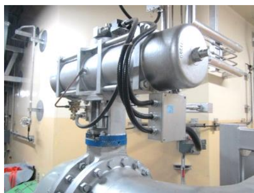
空気作動弁及び可とう電線管
