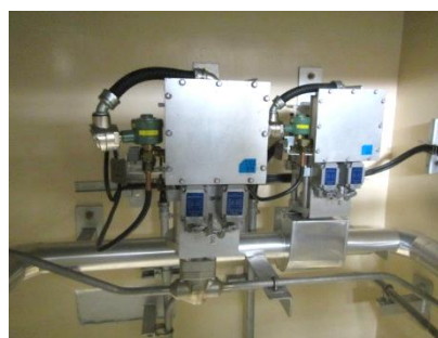
空気作動弁及び可とう電線管
