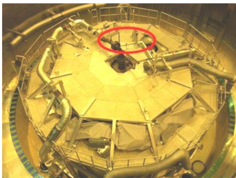
第 41-1-6 図：ベント配管の設置例
