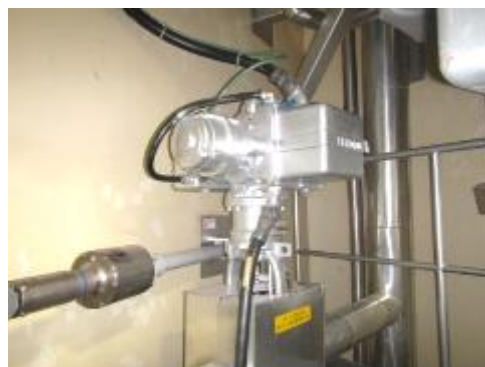
電動弁及び可とう電線管
