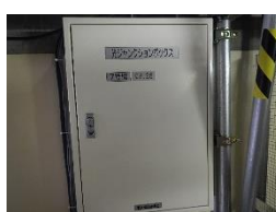
原子炉系多重伝送現場盤
