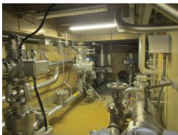
電動弁及び可とう電線管
