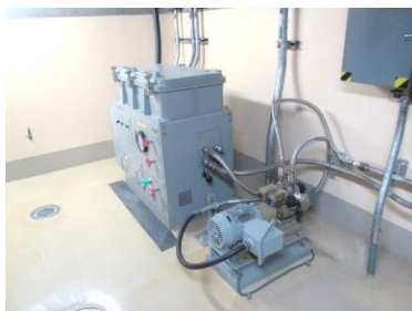
ダストサンプラ 及び可とう電線管
