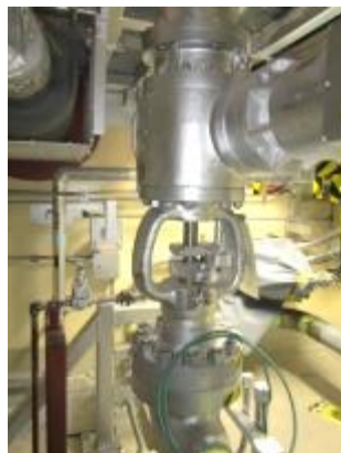
電動弁及び可とう電線管
