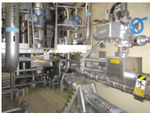
電動弁及び可とう電線管
