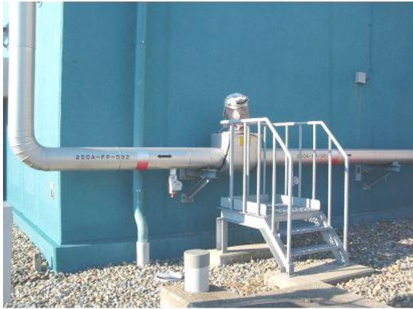
第 41-1-34 図：屋外消火配管への保温材設置状況
