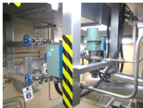
電磁弁及び可とう電線管
