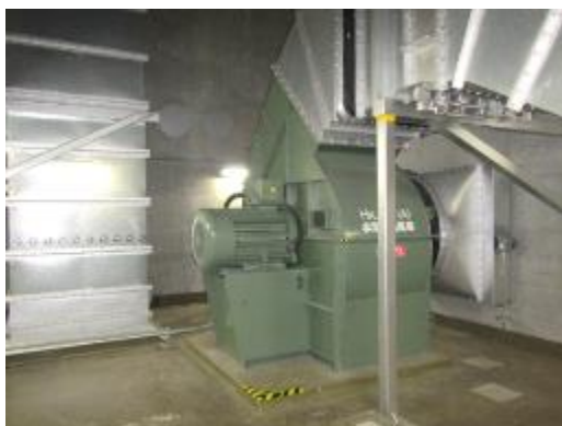
送風機，電動機及び可とう電線管
