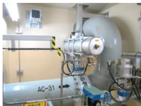
空気作動弁及び可とう電線管
