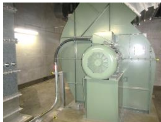
送風機，電動機及び可とう電線管
