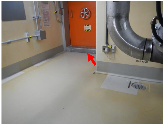
第 41-1-2 図：堰による拡大防止対策概要図
