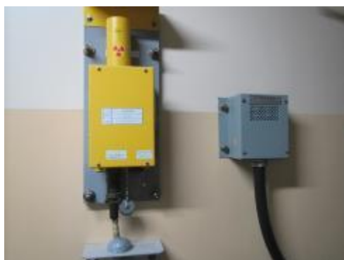
エリアモニタ及び可とう電線管
