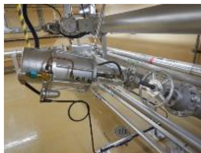
空気作動弁及び可とう電線管
