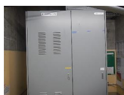
原子炉系多重伝送現場盤
