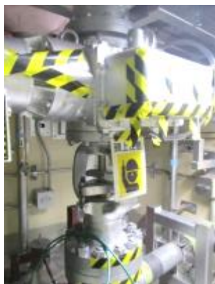
電動弁及び可とう電線管
