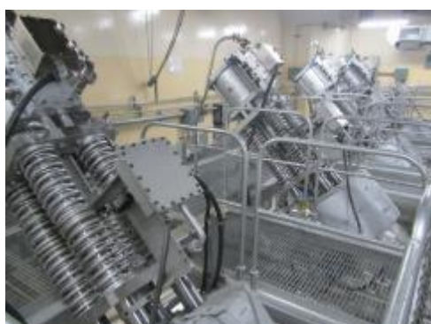
主蒸気隔離弁
