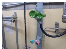
原子炉系多重伝送現場盤
