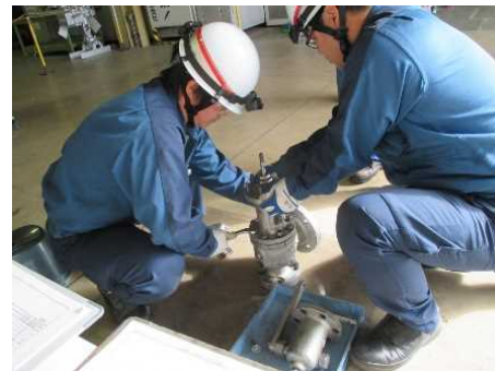
直営による安全弁の分解点検
