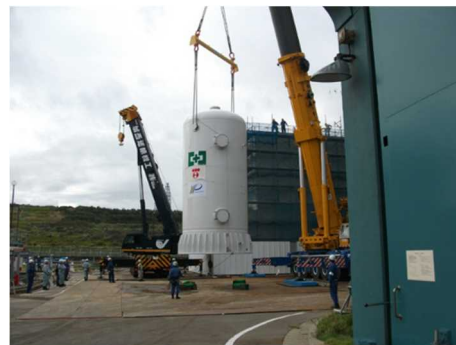
フィルタベント設備の搬入・設置 (柏崎刈羽原子力発電所7号炉)
