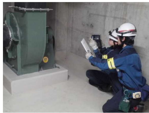
運転員の直営によるデータ採取（電動機の赤外線サーモグラフィ診断）
