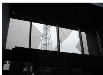
窓ガラスの破損
