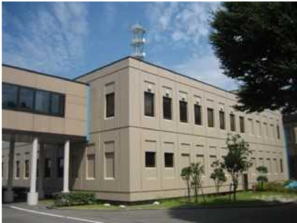
発災直後の事務所本館建物
