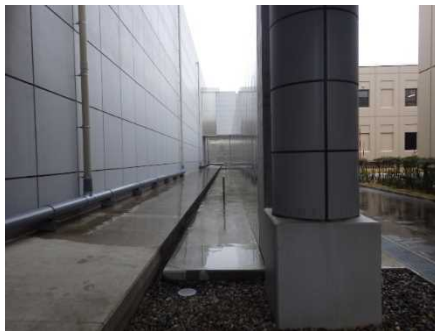
変位量識別ポールの設置状況
