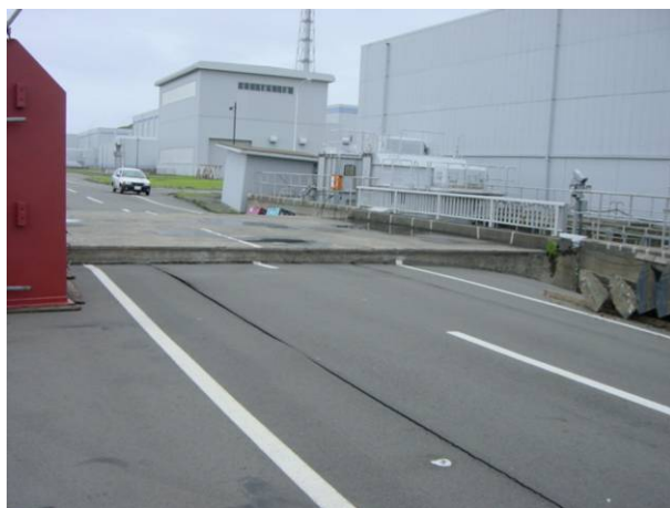
第4図 1号炉補機冷却用海水取水路付近の被災状況（アクセス性に支障がある段差）
