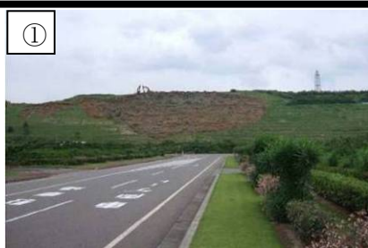
土捨場北側斜面（遠景）
