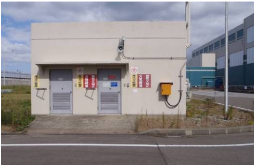
発電機用水素ガスボンベ建屋（6号炉）
