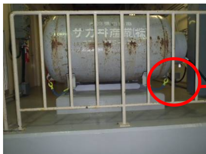
雑固体廃棄物焼却設備プロパン庫
