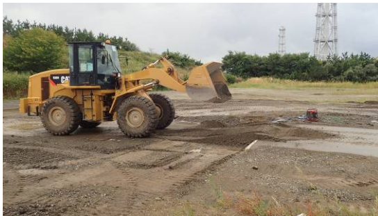
段差復旧状況③
