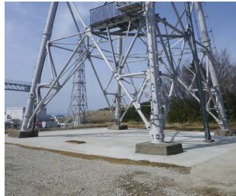
南新潟幹線 No. 1 送電鉄塔
