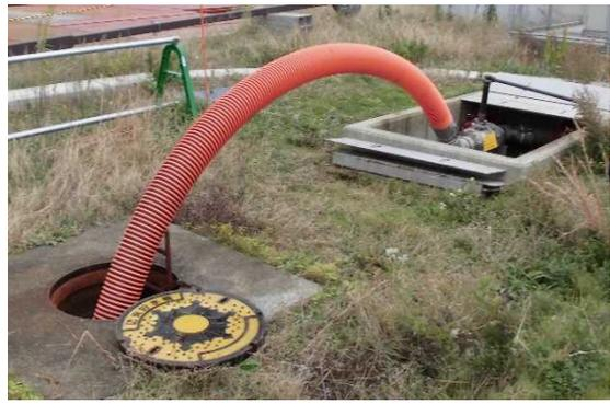
淡水貯水池から防火水槽への補給
