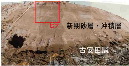
2号造成北側法面
