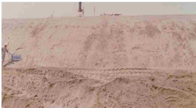
1号海水機器建屋西側法面 T.M.S.L.+3m~-2m 新期砂層・沖積層 (地点①)
