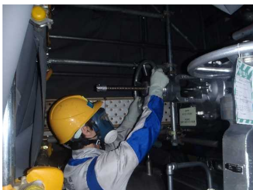
復水補給水系バイパス流防止措置
