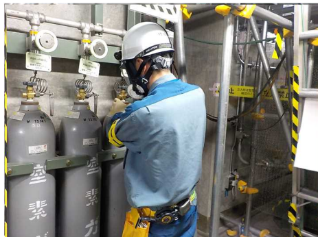
窒素ガスポンベ取替え
