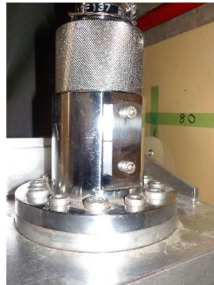
遠隔手動弁操作設備のリンク機構
