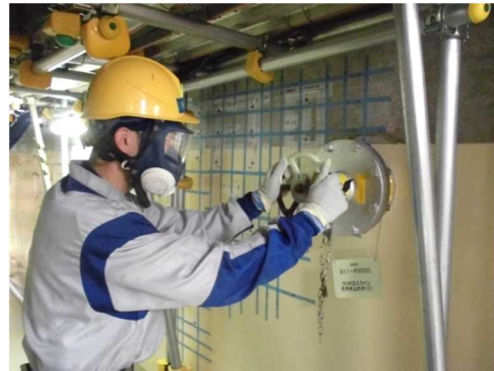
現場での注水操作
