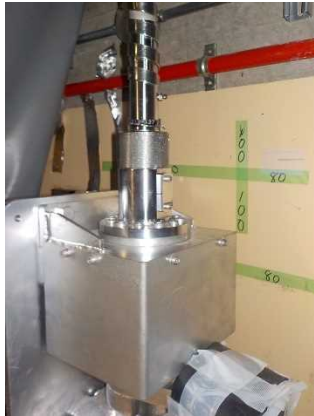
遠隔手動弁操作設備のリンク機構
