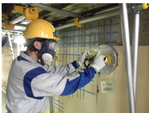
現場での注水操作 (残留熱除去系 (C) 注入配管使用の場合)
