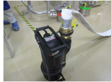
水中ポンプ設置状況
