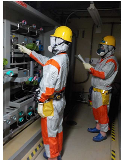
減圧状況の確認（現場）
