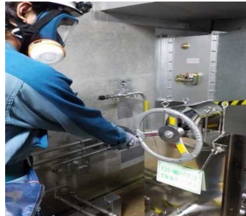
系統構成（遠隔手動弁操作設備）
