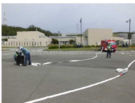
ホースを建屋接続口まで敷設
