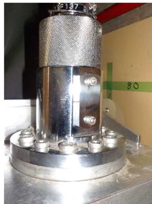
遠隔手動弁操作設備のリンク機構
