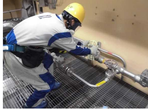
現場での注水操作
