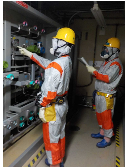
減圧状況の確認（現場）
