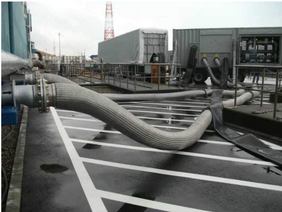
熱交換器ユニット設置
