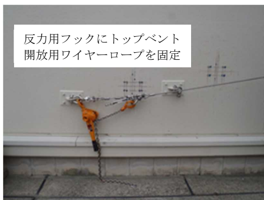
レバーブロックによる原子炉建屋 トップベント開放後の固定
