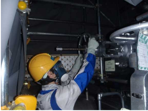
復水補給水系バイパス流防止措置
