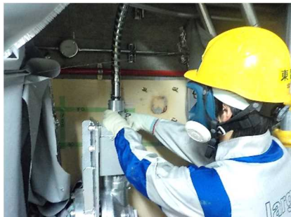
リンク機構の取外し操作
