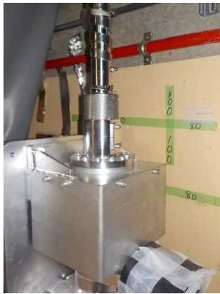
遠隔手動弁操作設備のリンク機構
