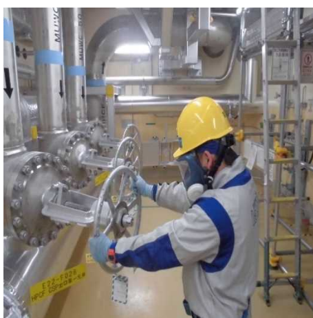
復水貯蔵槽出口ライン隔離
