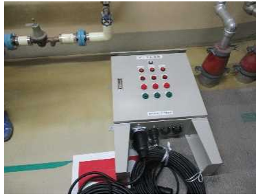
制御盤設置状況
