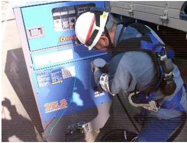
発電機設置状況
