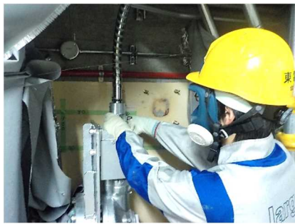
リンク機構の取外し操作
