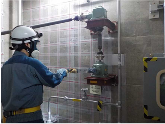
系統構成（遠隔手動弁操作設備）
