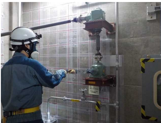
系統構成（遠隔手動弁操作設備）
