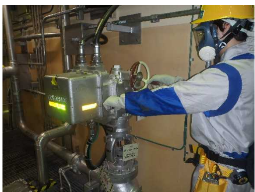
現場での注水操作
