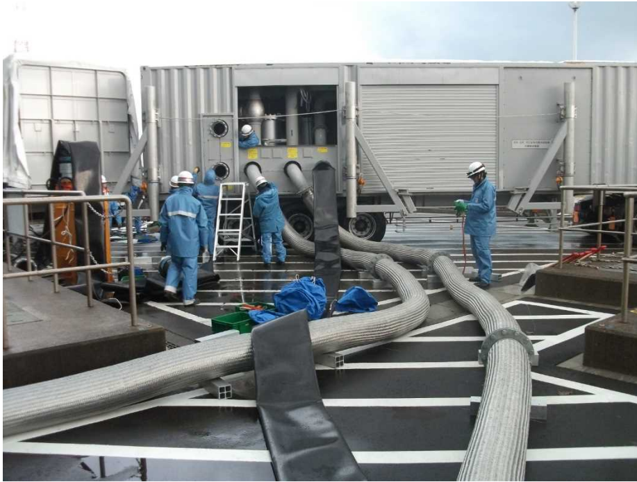
熱交換器ユニット設置作業
