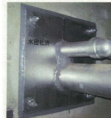
配管貫通部止水処置
