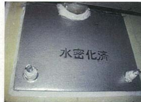
配管貫通部止水処置
