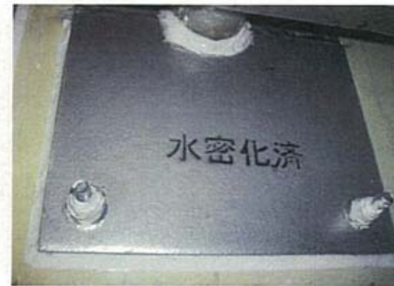
配管貫通部止水処置
