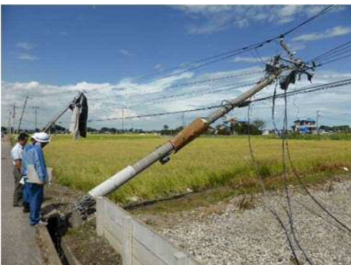
電柱の倒壊
