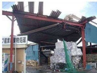
折板の損傷
