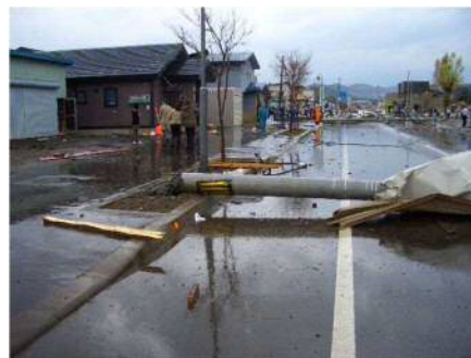
道路側へ倒壊した電柱
