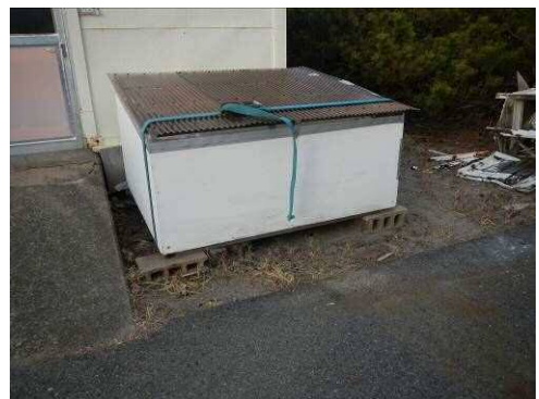
#350 鋼製ボックス
