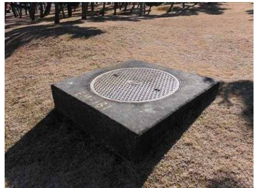
#186 マンホール蓋
