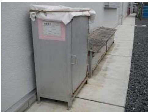
#287, #288 鋼製ボックス
