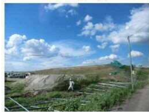
フェンスの被害
