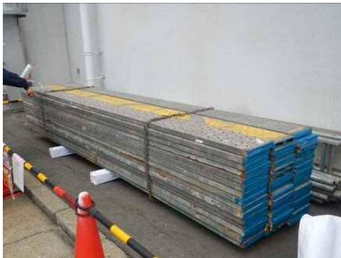
#272 足場材, 足場枠
