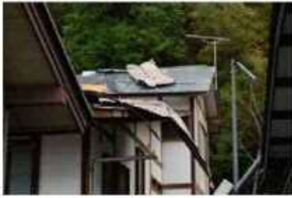
飛来物（鋼板製屋根材）の衝突
