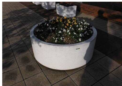
#121 コンクリートブロック
