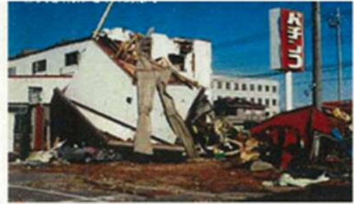
吹き飛ばされた建物
