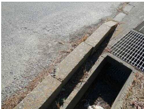
#417 コンクリートブロック
