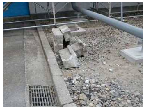
#314 コンクリートブロック
