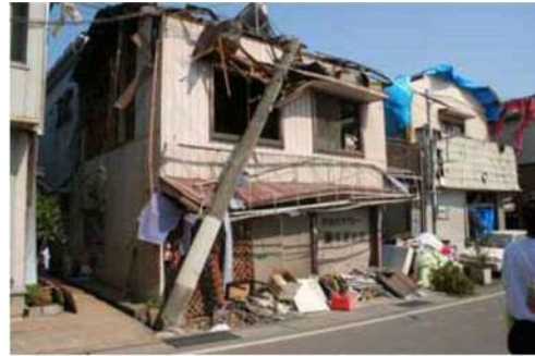
倒壊電柱に直撃された家屋
