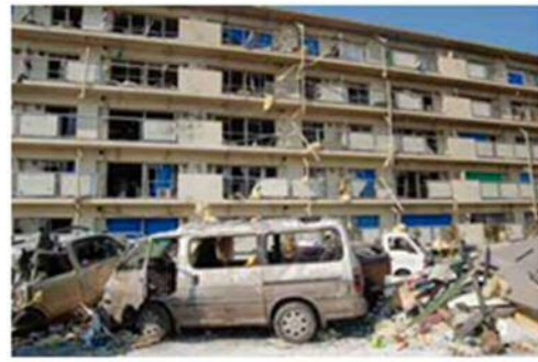
飛来物により被害を受けた住宅等
