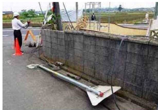
道路標識の折損
