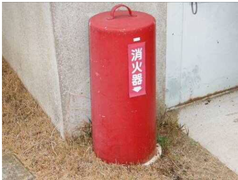
#33 消火設備格納箱
