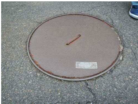
#316 マンホール蓋
