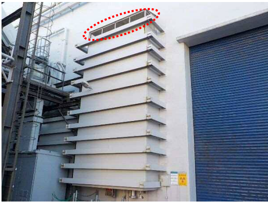
図2 ディーゼル駆動消火ポンプ室給気口
