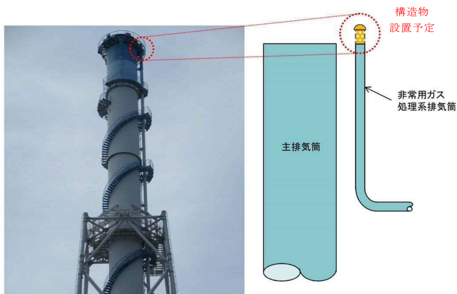
図2 非常用ガス処理系排気筒 概略図
