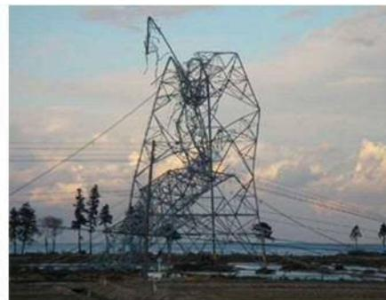
津波による隣接鉄塔の倒壊に伴う鉄塔の倒壊事例<sup>※2</sup>
