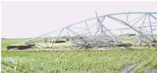
強風による鉄塔の倒壊事例②<sup>※1</sup>
