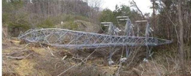
地震による斜面の崩落に伴う鉄塔の倒壊事例<sup>※2</sup>
