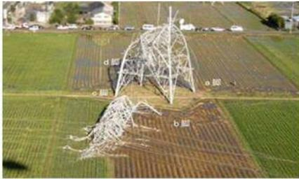
強風による鉄塔の倒壊事例①<sup>※1</sup>
