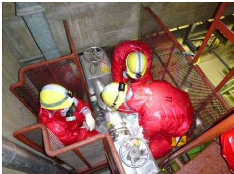
連絡配管閉止フランジ切替訓練
