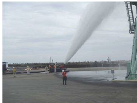
放水砲による放水（噴霧放射）
