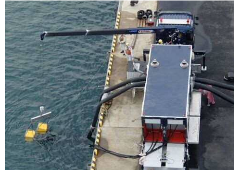
水中ポンプの設置状況
