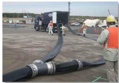
東海港での送水訓練 (ホース敷設)
