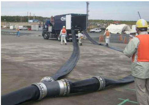
ホースの敷設状況
