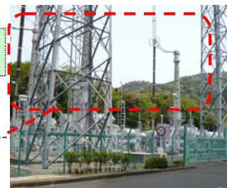
154kV 架線引込部 (イメージ図)
