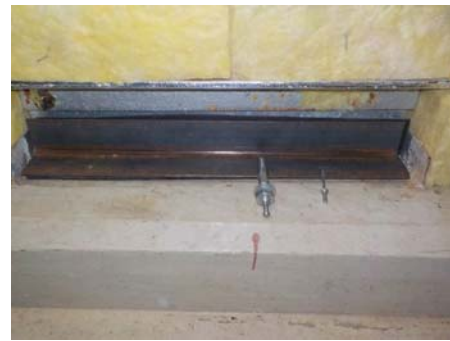
第7図 床貫通部模擬作業状況
