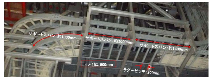
【実機サポート設置状況】
