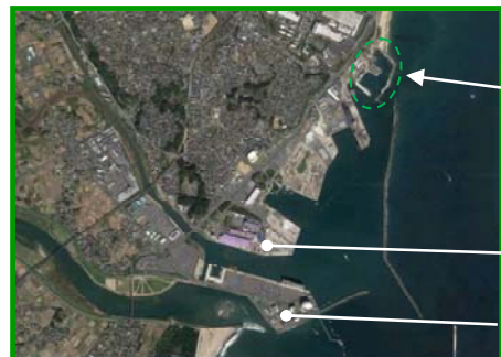
写真② 茨城港日立港区周辺状況
