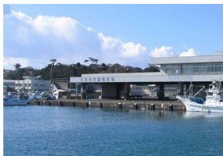
写真③ 久慈漁港状況
