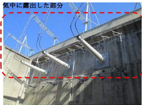
ii) 154kV 送電線引込部 (イメージ図)
