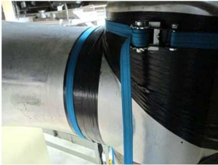
第3-2図 修復模擬作業状況
