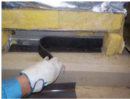
第7図 床貫通部模擬作業状況
