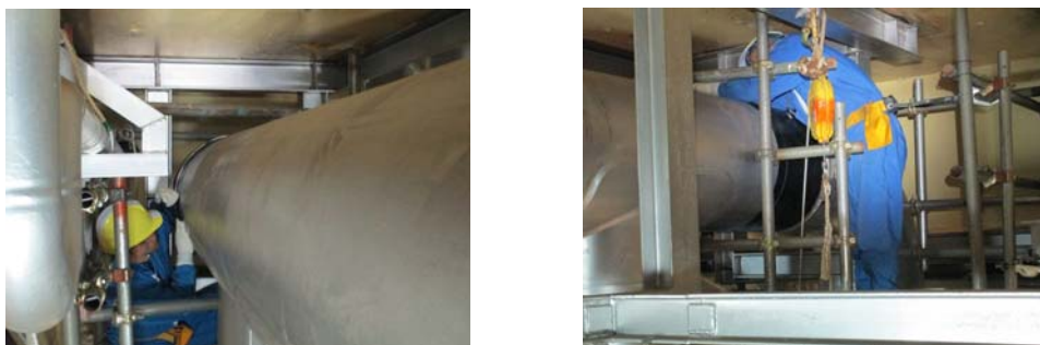
第2図 狭隘部作業状況
