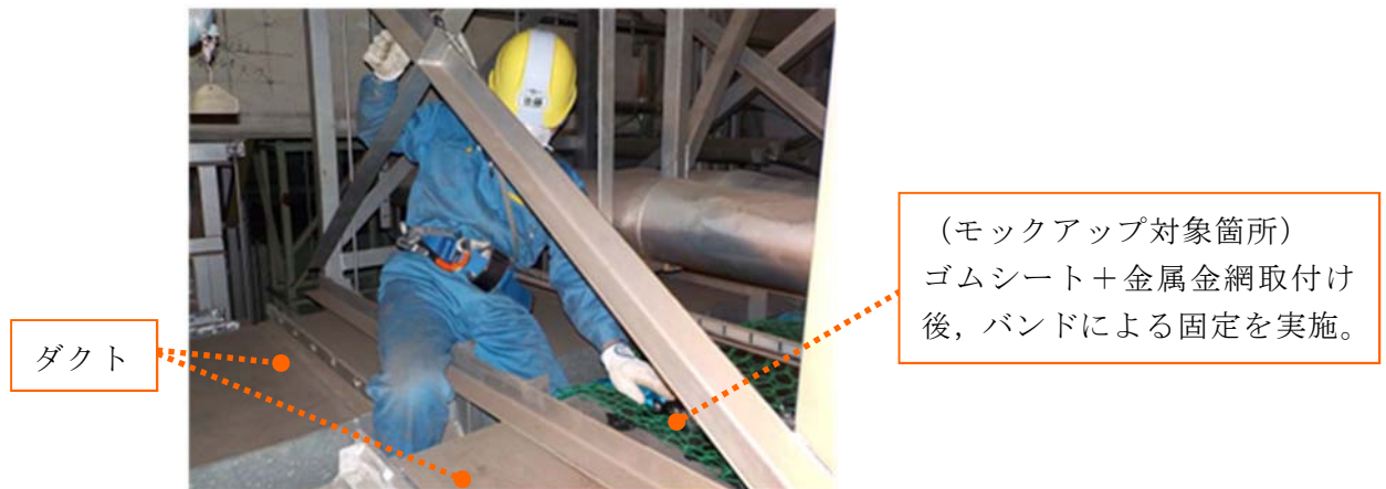
第5図 狭隘部作業状況
