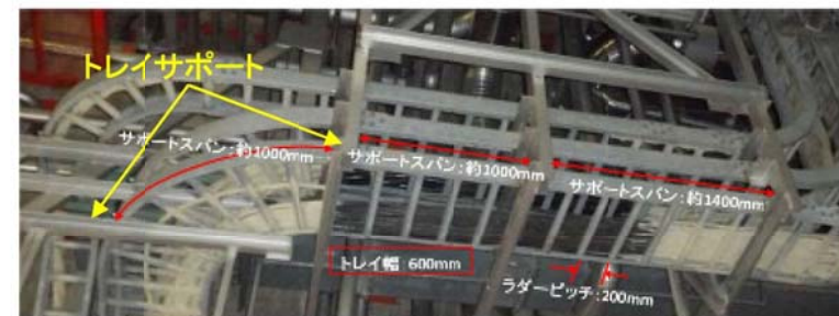
【実機サポート設置状況】
