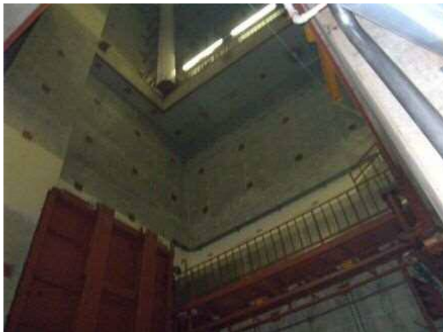
2階から3階機器ハッチ開口状況
