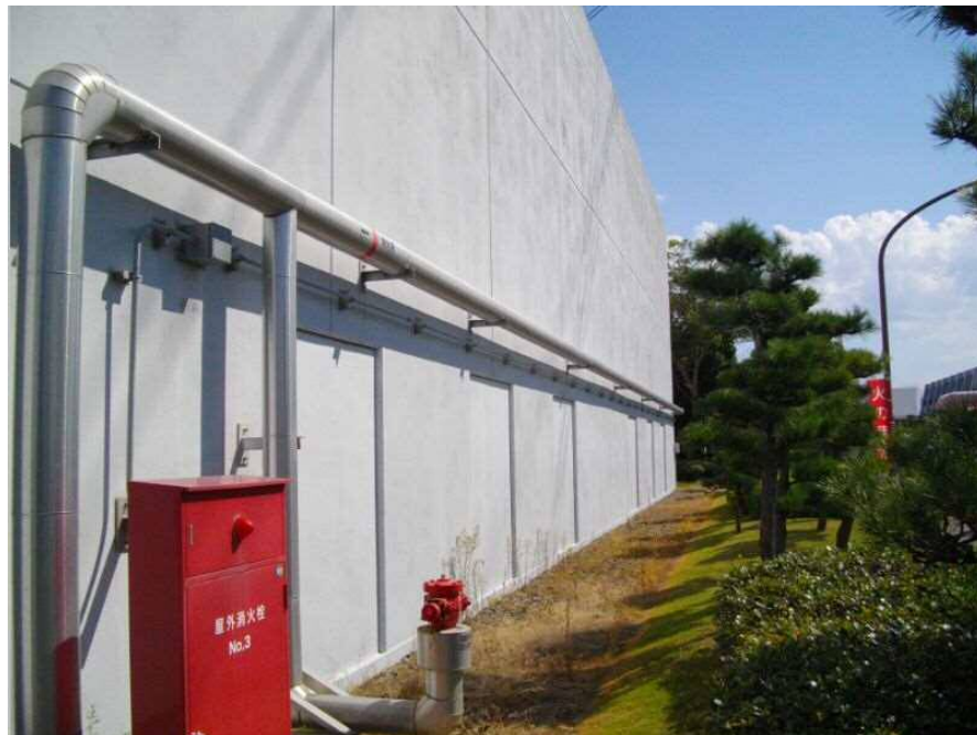
第1-26図 屋外消火配管への保温材設置状況
