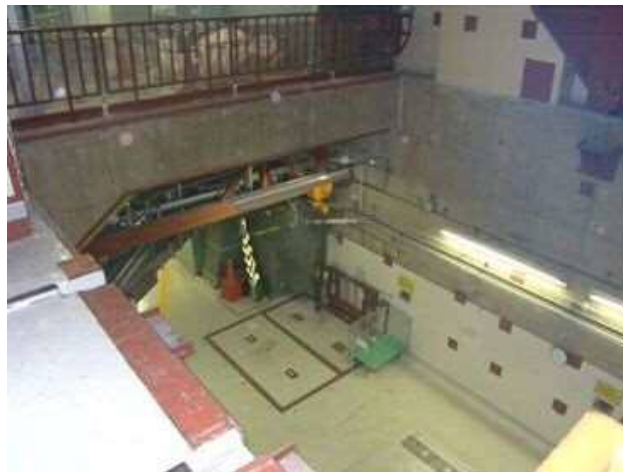
1階から2階機器ハッチ開口状況
