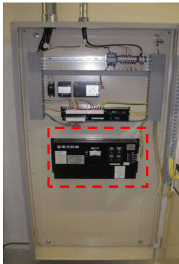
第1-22図 二酸化炭素消火設備制御盤内蓄電池
