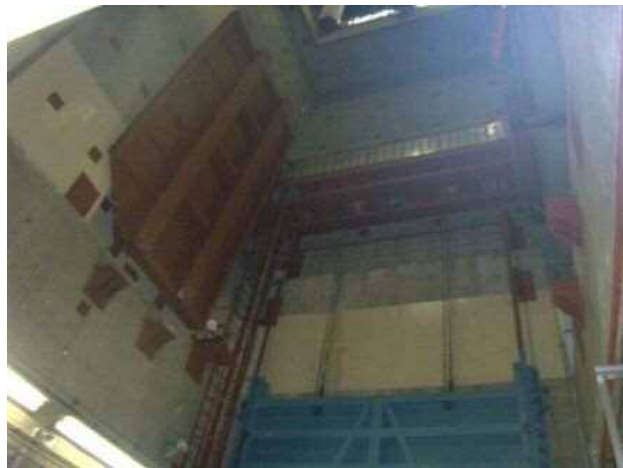
1階機器ハッチ開口状況
