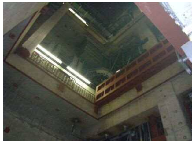
3階から4階機器ハッチ開口状況
