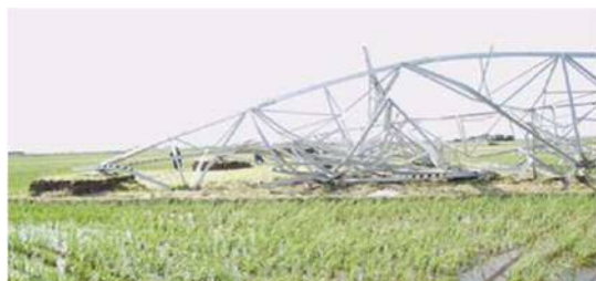
強風による鉄塔の倒壊事例② ※1
