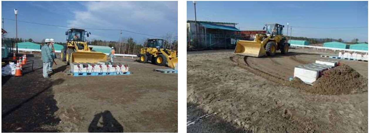
第6図 がれき撤去検証の写真
