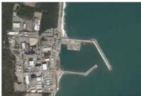
写真 東海第二発電所全景
