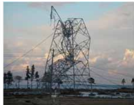
津波による隣接鉄塔の倒壊に伴う鉄塔の倒壊事例 2
