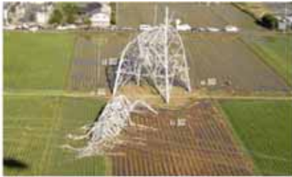
強風による鉄塔の倒壊事例 1
