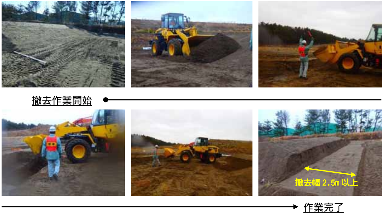
第 8 図 土砂撤去検証の写真
