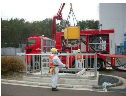
放射線防護具装着による送水訓練 (水中ポンプユニット設置)
