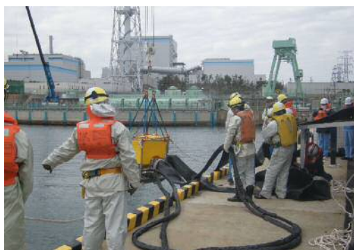
東海港での送水訓練 (水中ポンプ設置)
