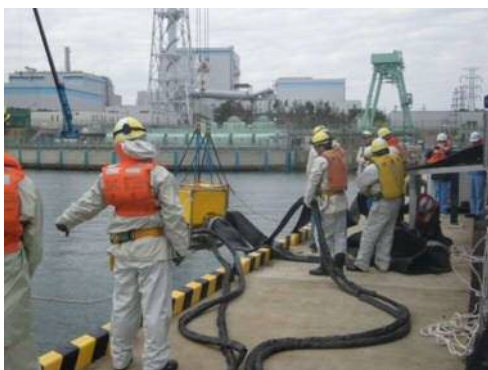
東海港での送水訓練 (水中ポンプユニット設置)
