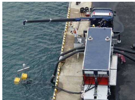
水中ポンプの設置状況
