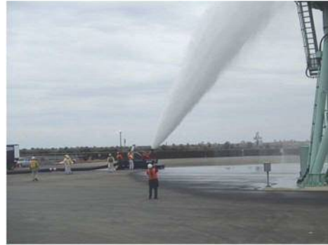
放水砲による放水（噴霧放射）
