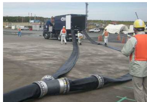
東海港での送水訓練 (ホース敷設)
