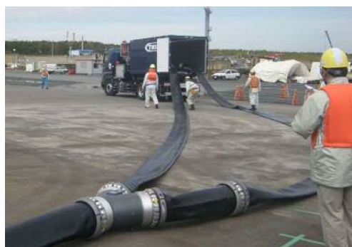
ホースの敷設状況
