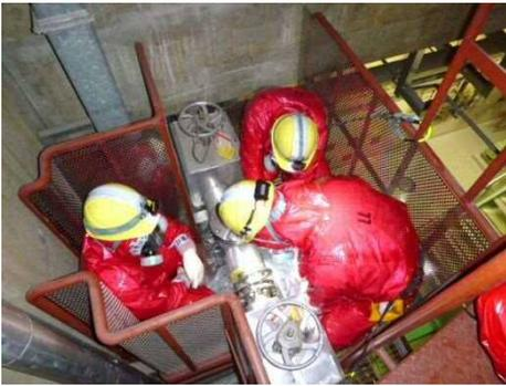
連絡配管閉止フランジ切替訓練
