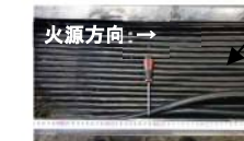
垂直: 隙間あり/ストップパあり 最大損傷長: 1,280mm
