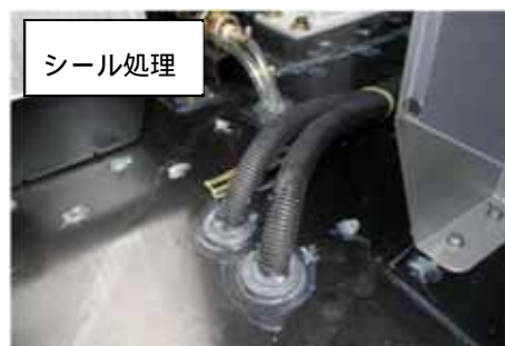
第1図 可搬型設備 小動物対策例(1/2)
