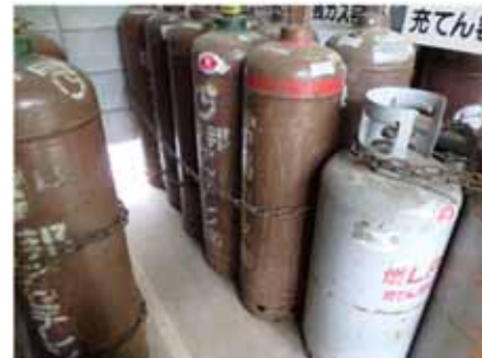
協力会社ボンベ小屋 アセチレン・プロパンボンベ設置状況
