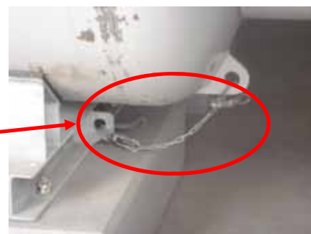
焼却用プロパンボンベ庫 プロパンボンベの固縛状況
