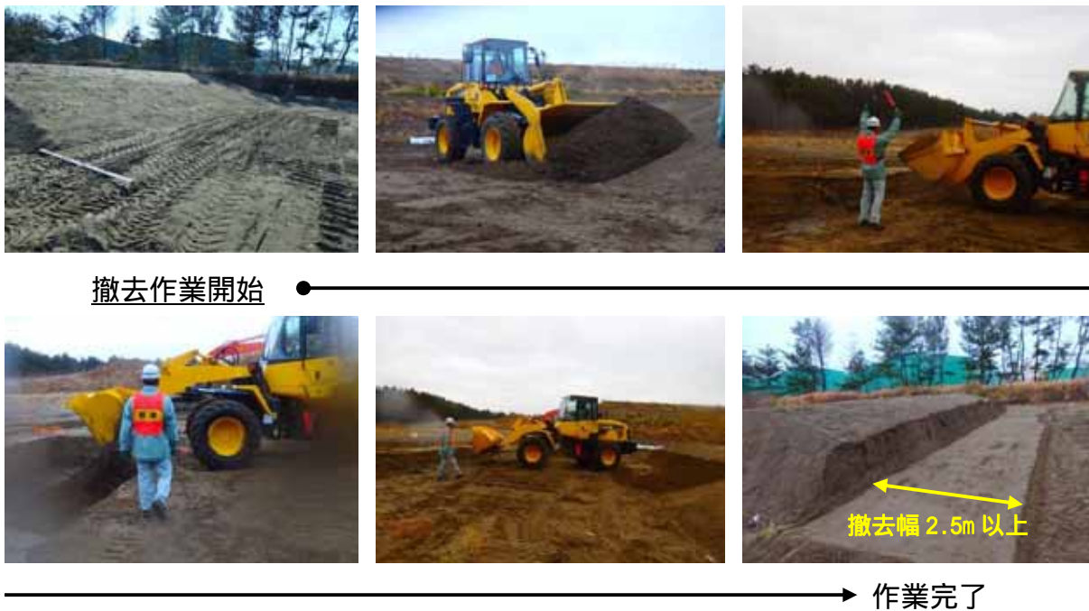
第 8 図 土砂撤去検証の写真
