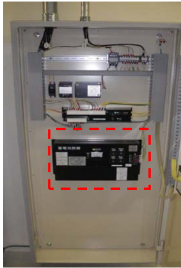
第1-25図 二酸化炭素消火設備制御盤内蓄電池
