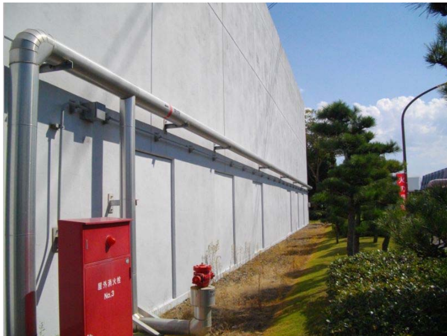
第1-30図 屋外消火配管への保温材設置状況
