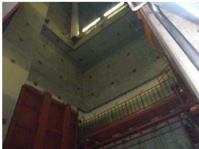
2階から3階機器ハッチ開口状況
