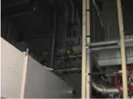
系統構成 （ 補助ボイラ冷却水元弁 ）
