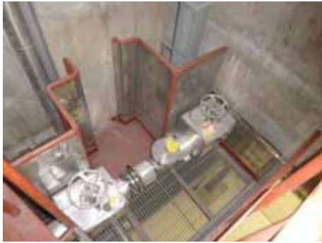
作業場所（全体）
