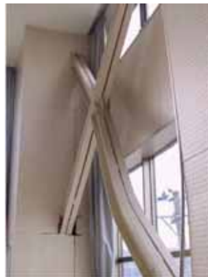
間柱脚部アンカーボルト破断
