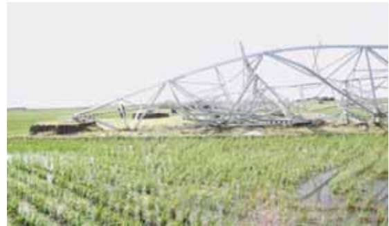
強風による鉄塔の倒壊事例 1
