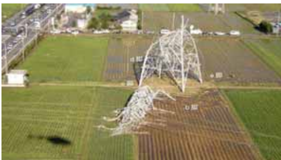
強風による鉄塔の倒壊事例 1
