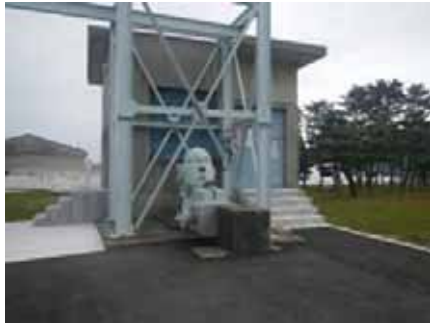
T/H 消火用ディーゼルポンプ室
