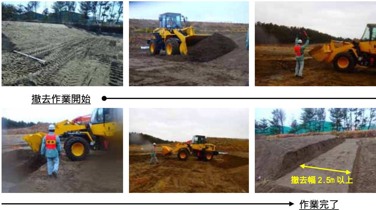
第 8 図 土砂撤去検証の写真
