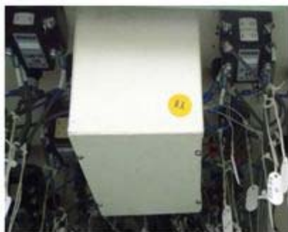
厚さ 1.6mm の金属製筐体の例
