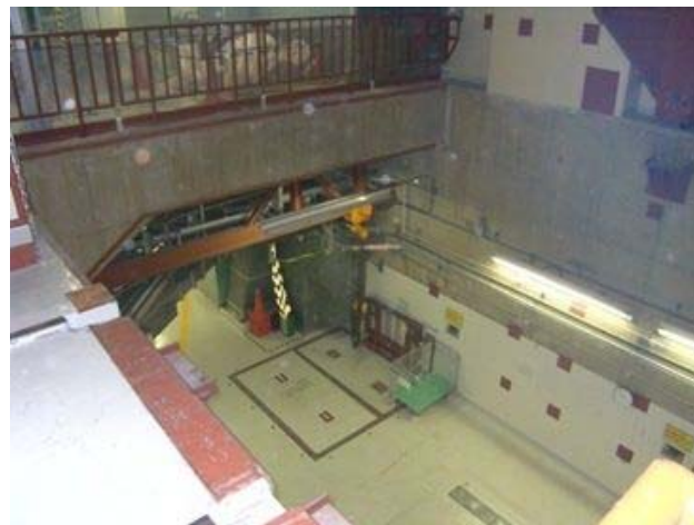
1階から2階機器ハッチ開口状況
