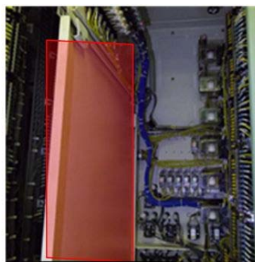
厚さ 3.2mm の金属バリアと 3cm 以上の離隔距離の例
