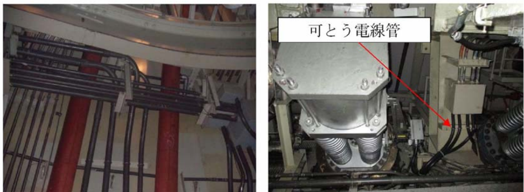
機器へのケーブル取合状況 (主蒸気内側隔離弁との取合)
