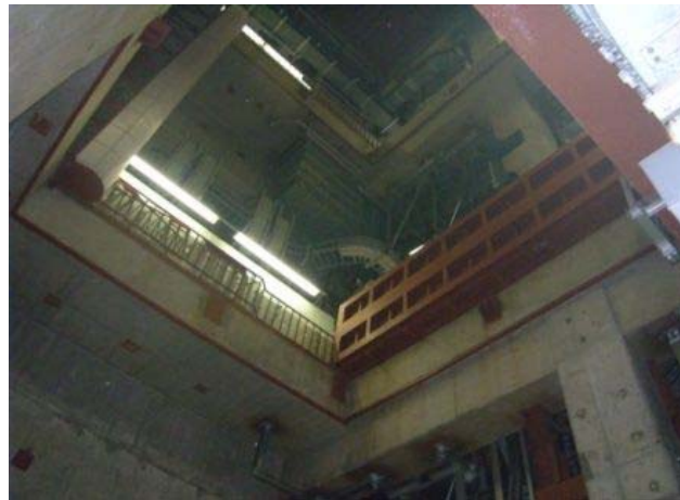
3階から4階機器ハッチ開口状況
