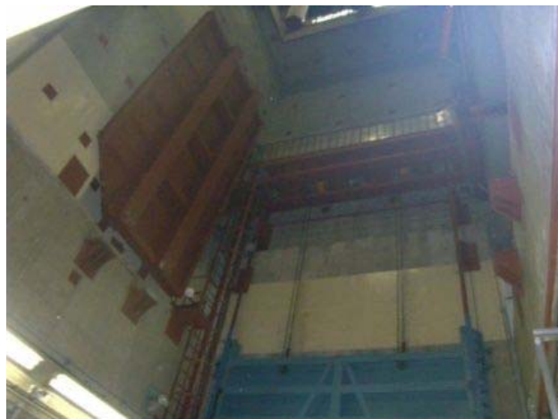
1階機器ハッチ開口状況
