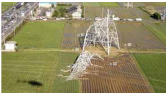
強風による鉄塔の倒壊事例 1
