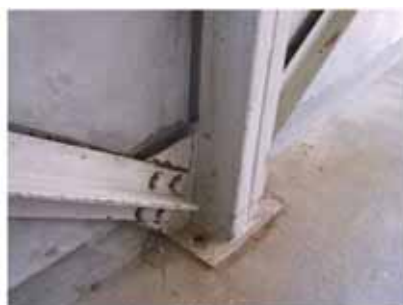
間柱脚部アンカーボルト破断
