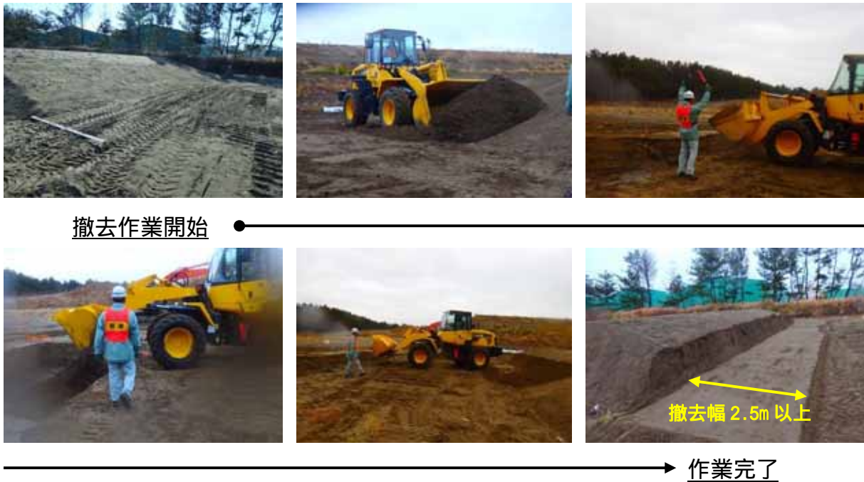
第 8 図 土砂撤去検証の写真
