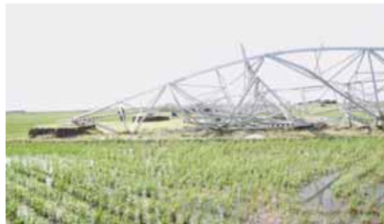
強風による鉄塔の倒壊事例 1
